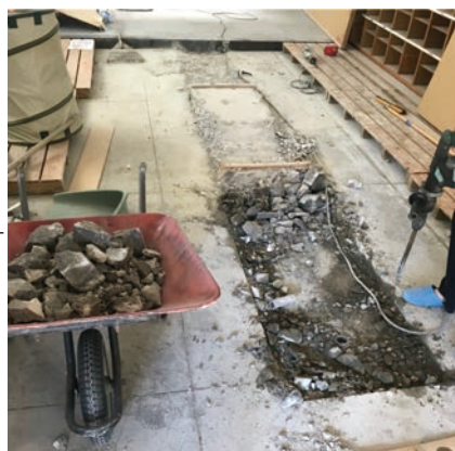
施工中(土台はつり)
