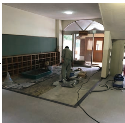
施工中(セメント打ち)
