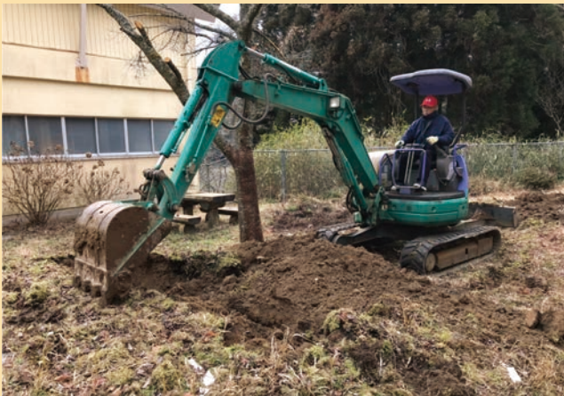
池の基礎工事を手伝って頂きました!
